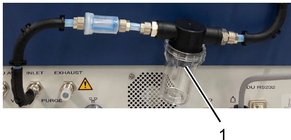
Fig. 10: Comprobación del separador de líquidos
