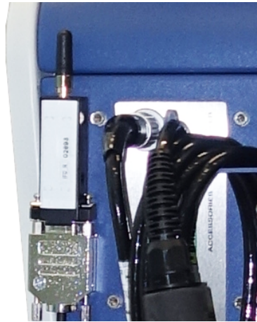
Abb. 21: Befestigung des Transmitters mit Klettband an einer freien Stelle
