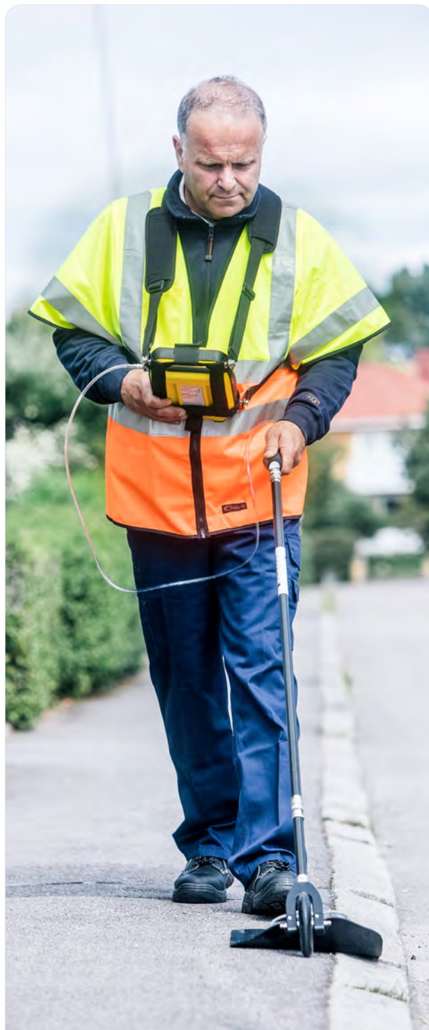
巡检人员沿管道敷设路线进行巡检。
