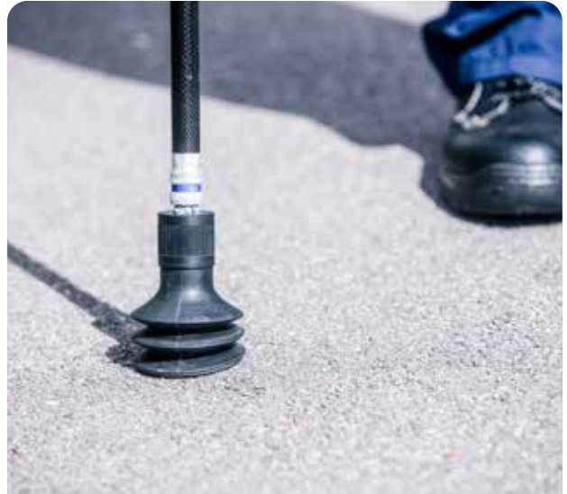
Die Vakuumglocke dichtet den Boden luftdicht ab und zieht die Luft durch den Straßenbelag.
