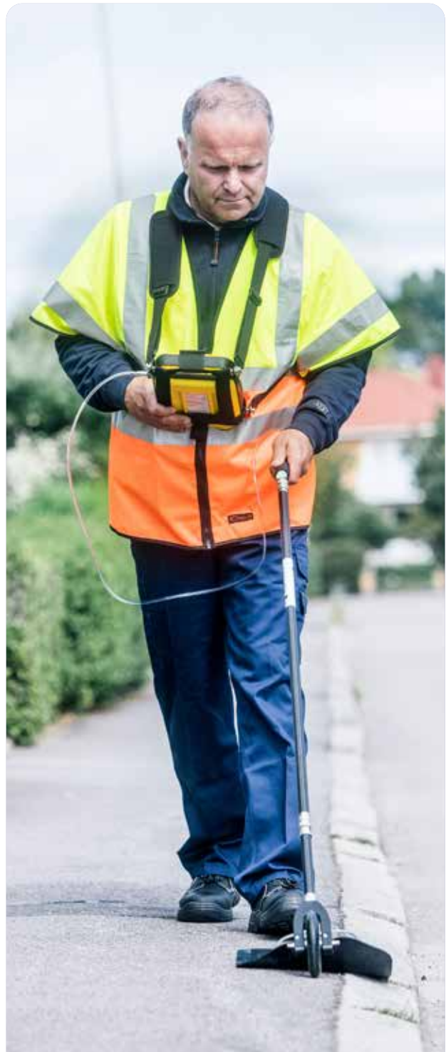
Ein Mitarbeiter läuft ein Rohrleitungsnetz ab.
